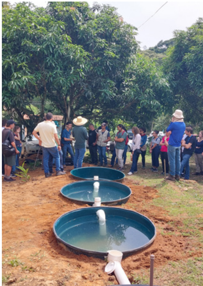
Instalação de Fossa Séptica Biodigestora em propriedade rural na Serra do Japi, em Jundiá
